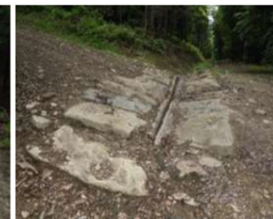
Wodospust odprowadzający wodę z drogi do lasu.
